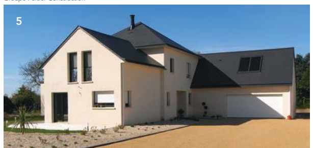
Groupe Peltier Construction
